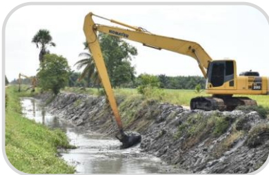
ดูแล ทางระบายน้ำ
